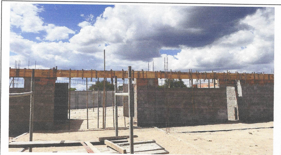
FOTO 52: Chapisco e forma das vigas superiores
