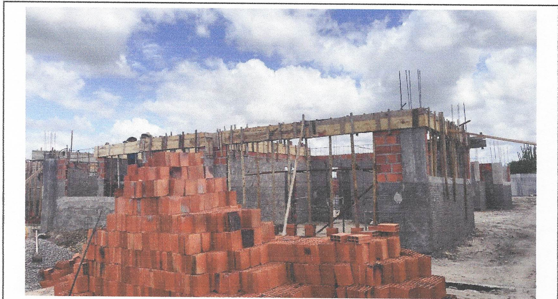
FOTO 49: Concretagem da viga superior
