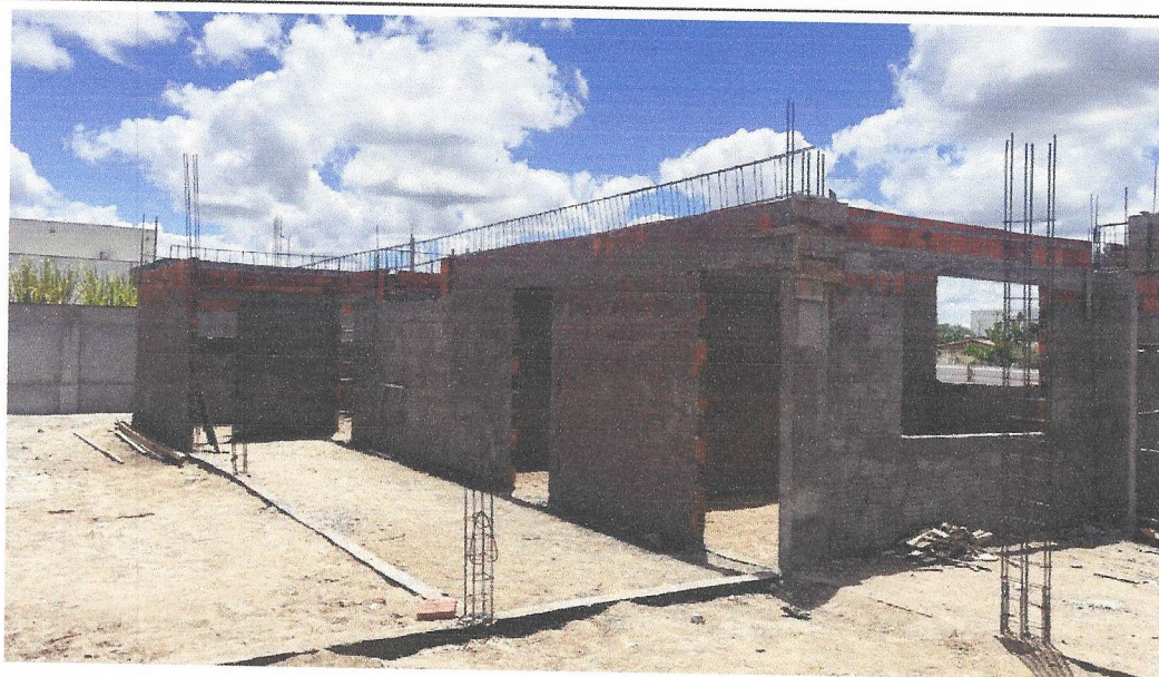
FOTO 46: Inserção das armaduras das vigas superiores
